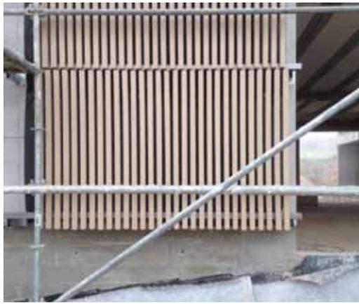
Rastres horizontales cada 120 cm aproximadamente, de tubo de acero galvanizado 80.50.2. Las lamas de composite, perfiles huecos de 45 x 45 mm, se fijan con escuadras de acero galvanizado al rastrel horizontal. Éstas permiten el juego de la fuerte dilatación del perfil (casi 1 mm/m)
